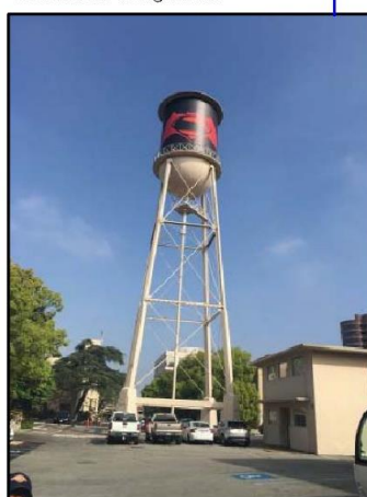
Water tank on ground ບ່ອນເກັບນໍ້າເທິງພື້ນດິນ
