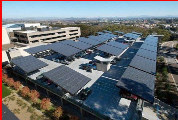
ບ່ອນຈອດລົດເທິງດາດພ້າ 在屋顶上有停车库
